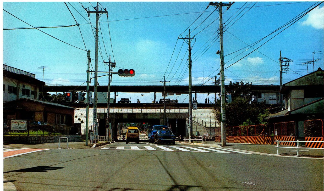
都市計画街路2・2・4号線と中央線の立体交差
