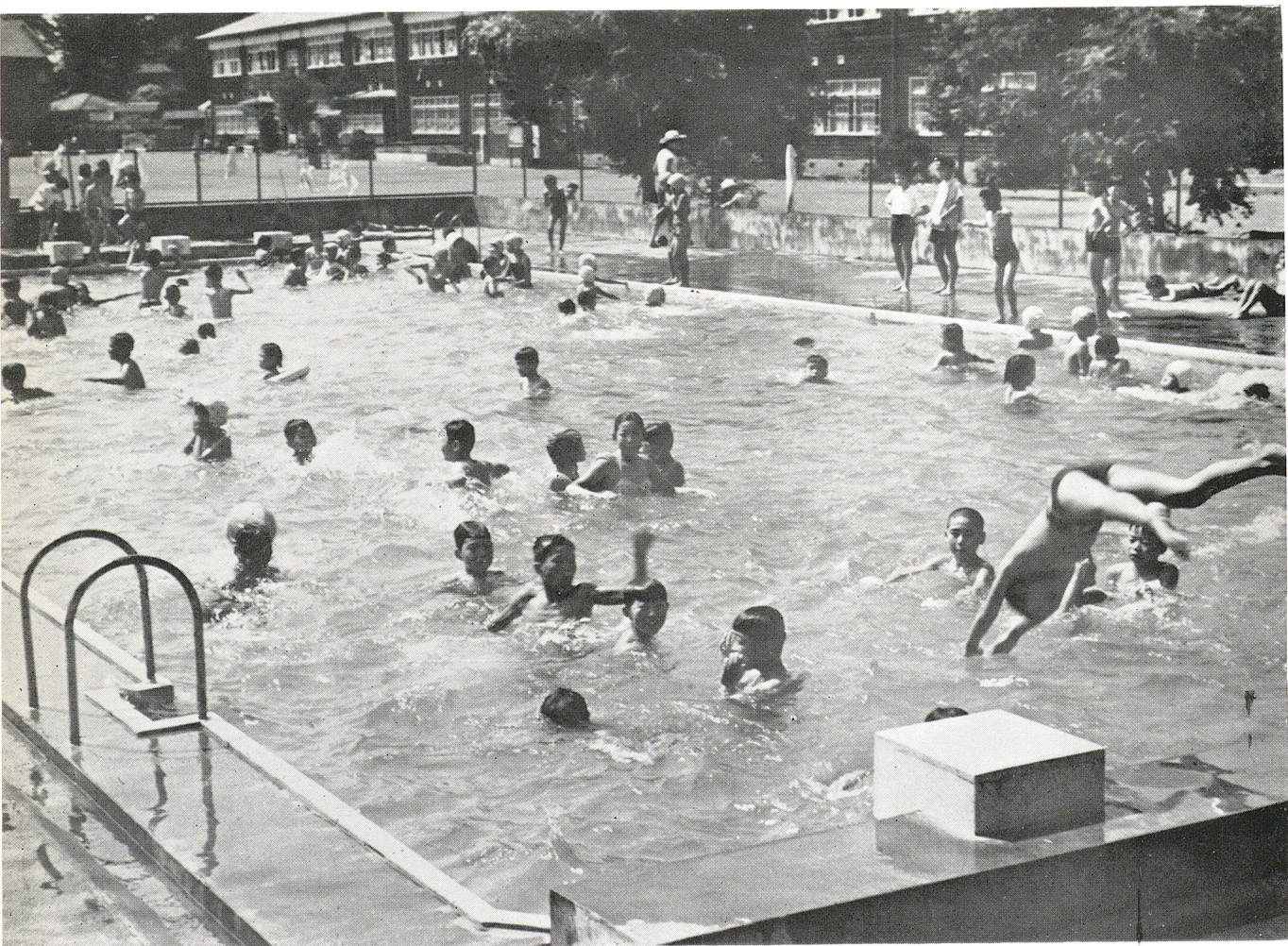
小 中 学 校 プ ー ル 設 置 状 況
