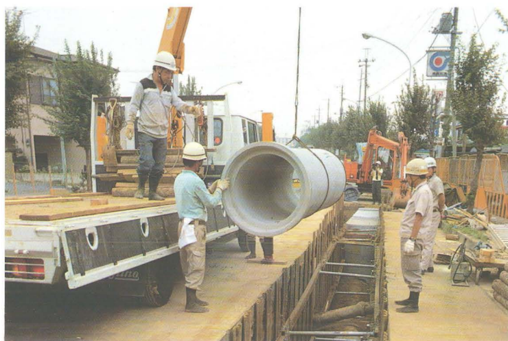
下水道埋設工事
