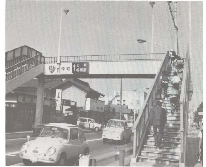
甲州街道仲町歩道橋
