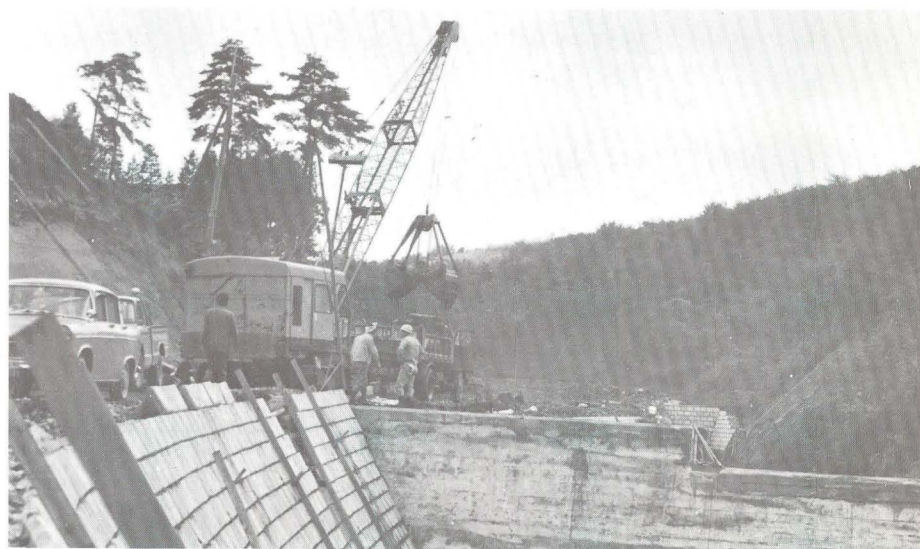
市道の改修工事
