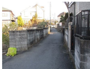
平山城址公園駅と北野街道を斜めに結ぶ市道は幅員2～6mで、歩行者の安全性を高める整備を推進
