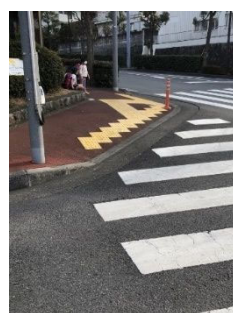
北野街道の整備に合わせて交差点部における勾配の緩和が進められています
