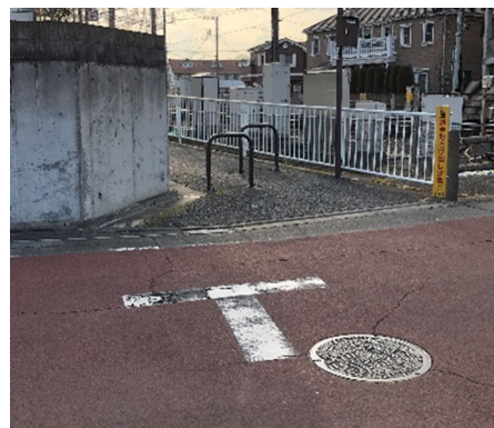
道路との交差部分に警告する視覚障害者誘導用ブロックがない
