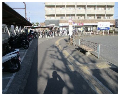
整備されたバス停留所を示す視覚障害者誘導用ブロック
