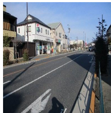
道路改良が進められている北野街道
