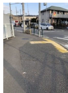
北野街道の整備に合わせて交差点部における勾配の緩和が進められています
