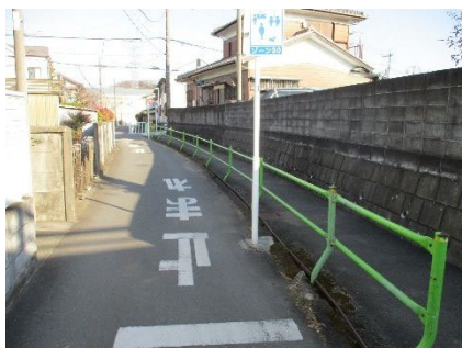
都道の東側は、水路のふた掛けで歩道を整備
