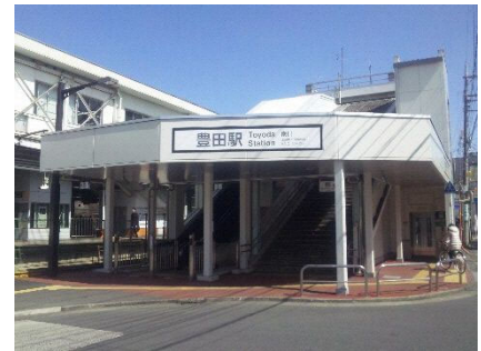
整備された南口のエレベーター（右）とエスカレーター（左）
