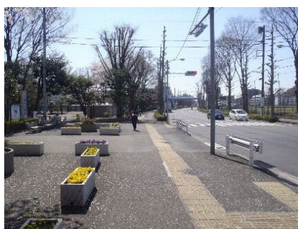
個別的な段差や商店との段差が解消され、視覚障害者誘導用ブロックが設置された都道235号線
