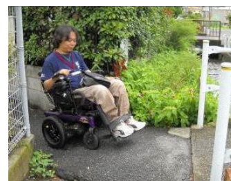
道路幅員は1.2mで、沿道建築物との一体的な整備と、水路接続部での勾配緩和や見通しの改良が必要な市道（L2-2号線）
