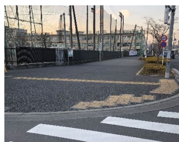
七生中学校前は学校入口までの視覚障害者誘導用ブロックの設置が望まれます
