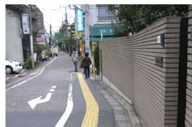
外側線と視覚障害者誘導用ブロックの設置事例（東京都世田谷区）
