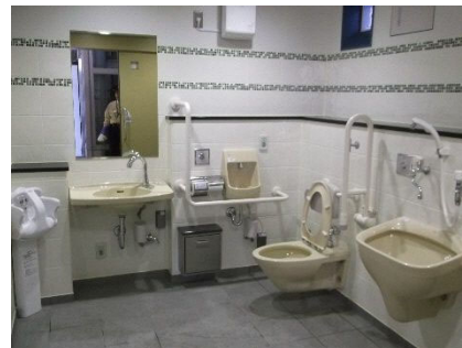
バリアフリートイレが設置されている
