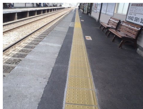
ホーム上に整備された内方線付点字ブロック
