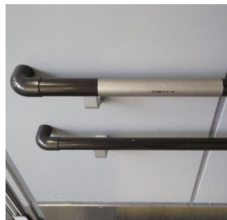
階段には2段手すりが設置され、手すりには点字表示がされている
