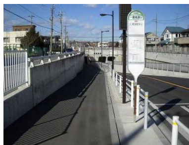
京王線との立体交差が完了
