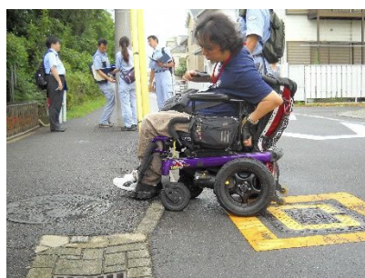
個別的な段差の解消や、グレーチングの網目の改良などを実施
