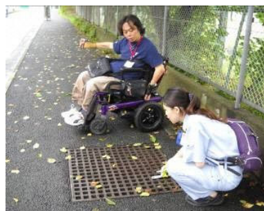
個別的な段差の解消や、グレーチングの網目の改良などを実施
