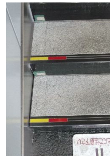
階段のステップ面のエッジサインは端部のみ
