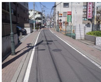
車道の幅員を縮小し、インターロッキング舗装により確保された歩行帯
