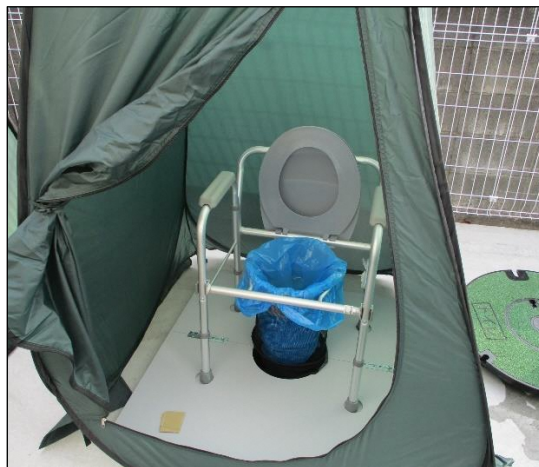
【下水道 BCP に基づく訓練の様子（左）、マンホール型トイレ施設（右）】
