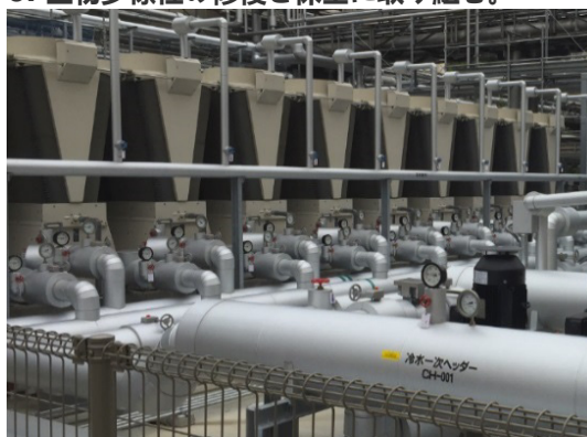
高効率チラー(水冷却装置)2015年度導入
