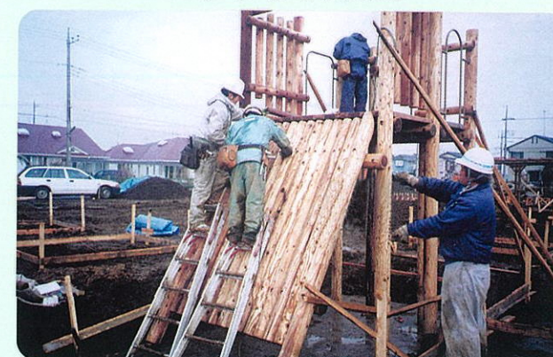
工事中（遊具設置）
