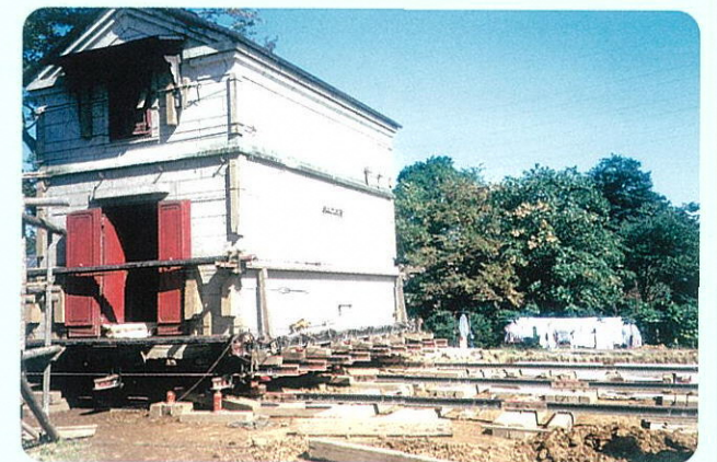
枕木とレールを使い移動させます。
