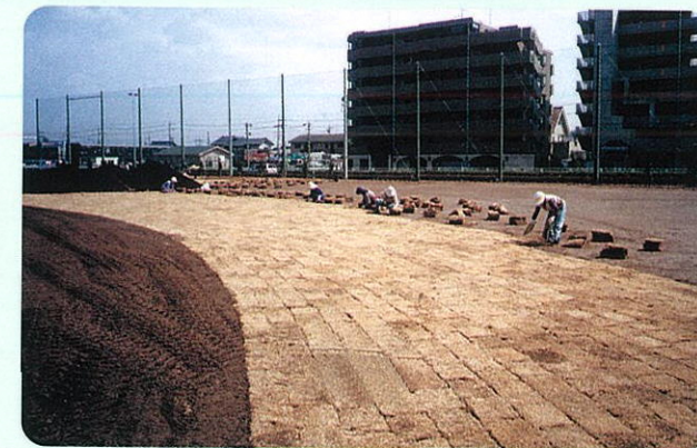
工事中（芝張り）
