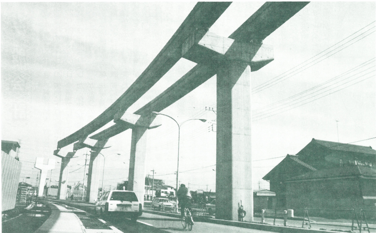
▲平成9年度の完成を目指し工事が進む多摩都市モノレール
