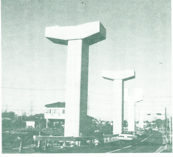
モノレール建設工事進む(新井にて)
