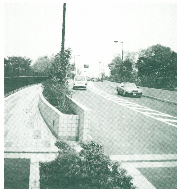
3月に開通した東豊田陸橋
