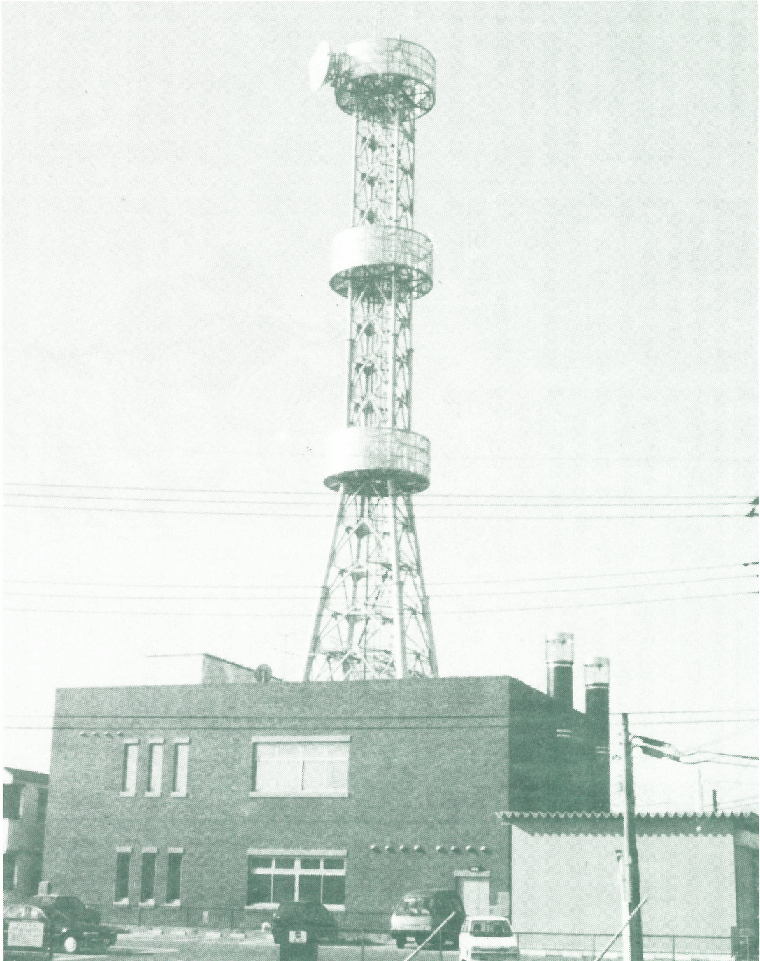
完成まじかの防災情報センター（市民会館東隣り）
