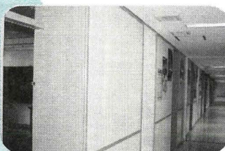
▲室内の壁を補強(二中南校舎)
