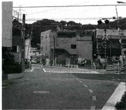
▲バリアフリー化により改良された百草園駅前
