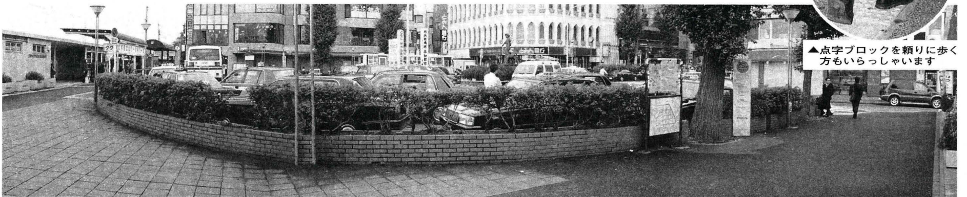
▲撤去作業後、すっきりした歩道
