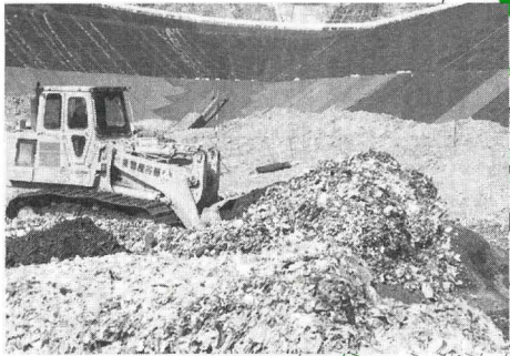
▲最終処分場 埋め立ての様子
