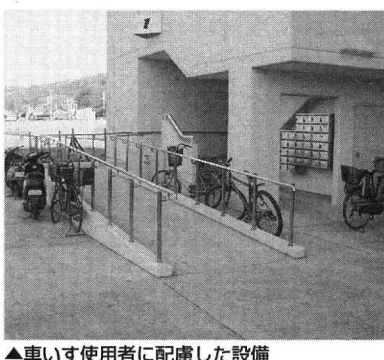
▲車いす使用者に配慮した設備
