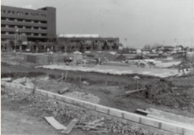
▲市役所新庁舎完成（昭52）
