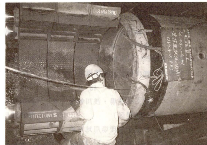
公共下水道管きょ埋設
