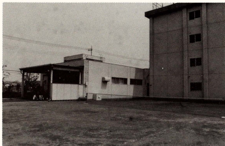
平山中給食室新築
