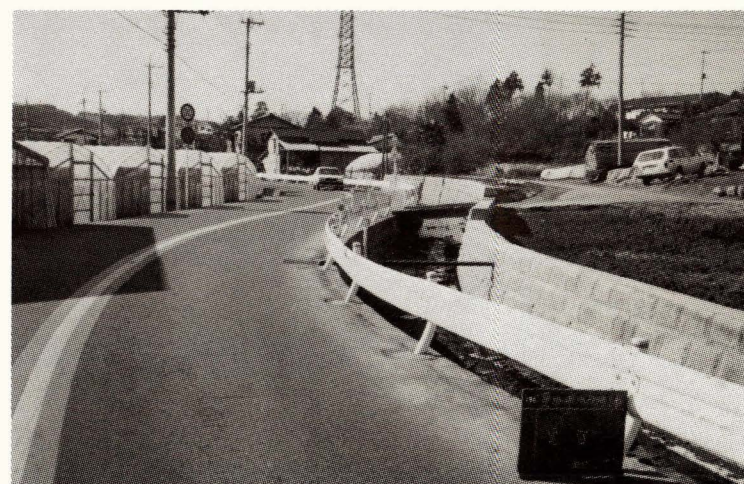
豊田用水路改修
