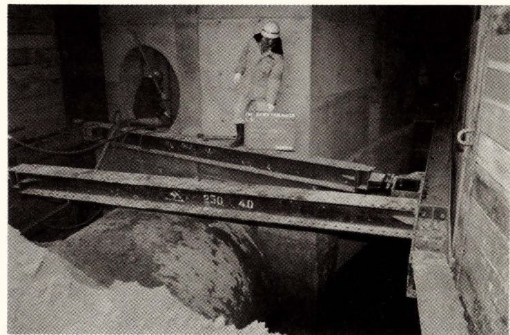
黒川都市下水路管渠埋設
