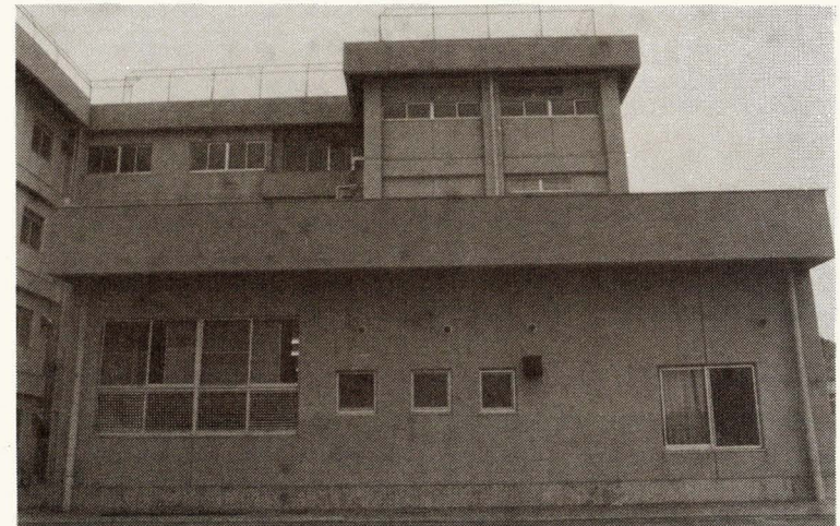
三沢台小学校給食室新築
