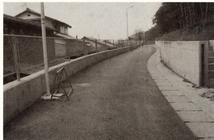
補助2号線道路新設
