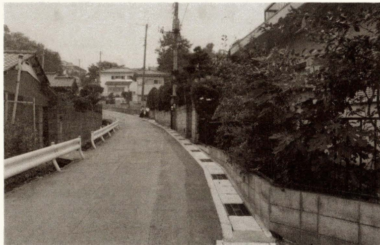
姥久保 2 号線側溝新設
