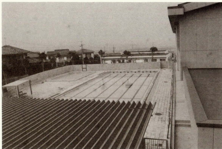
三沢台小学校プール新築
