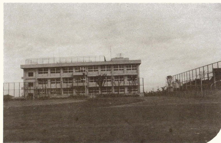
三沢台小学校新築
