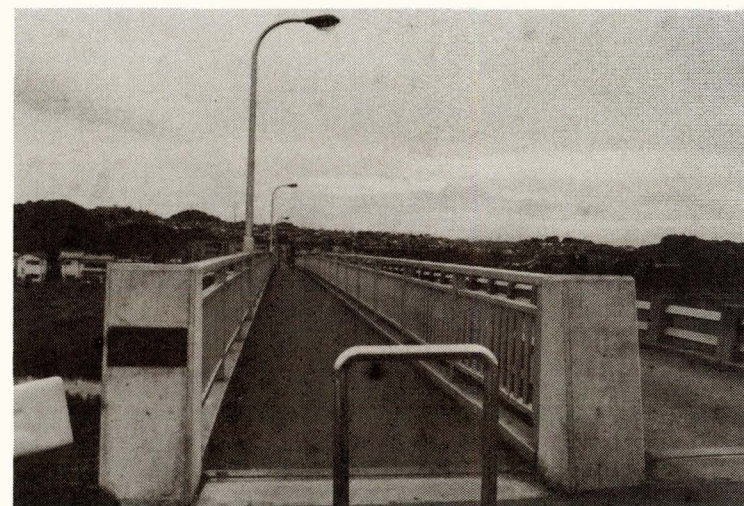
長 沼 橋 歩 道 設 置
