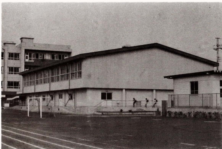
旭が丘小学校屋内運動場新築
