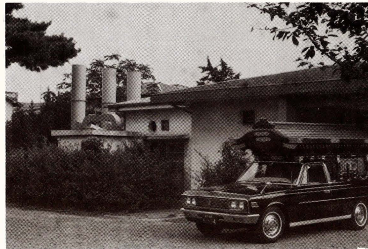
火 葬 場 火 葬 炉 改 修
