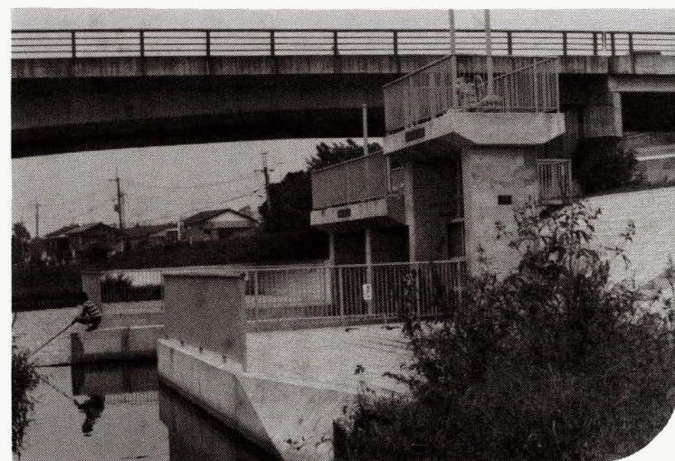
浅川南第4排水区樋管設置
