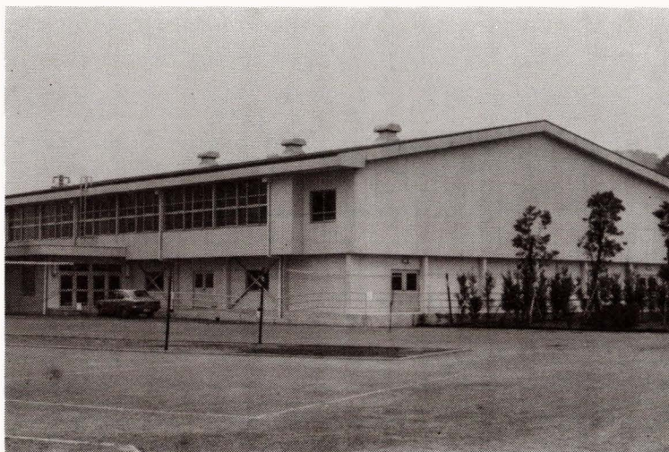
三沢中学校屋内運動場新築
