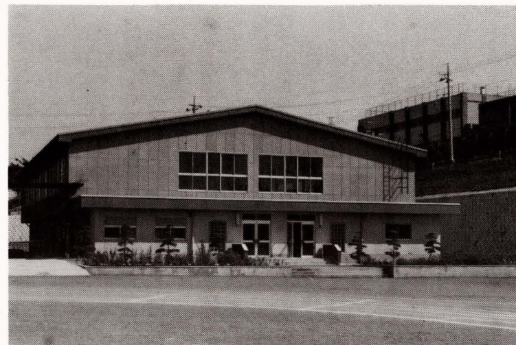
程久保小学校屋内運動場新築
