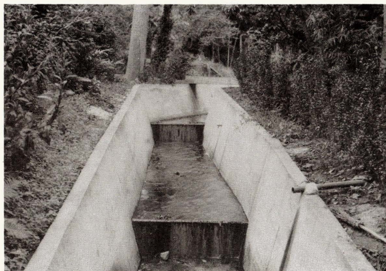
滝合水路改修
