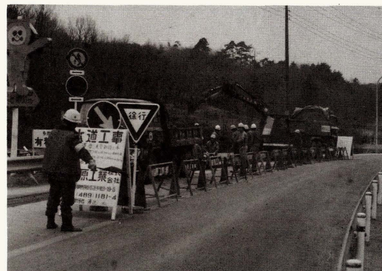
配水管新設（受託水道事業会計） 程久保 201～344 番地先間
