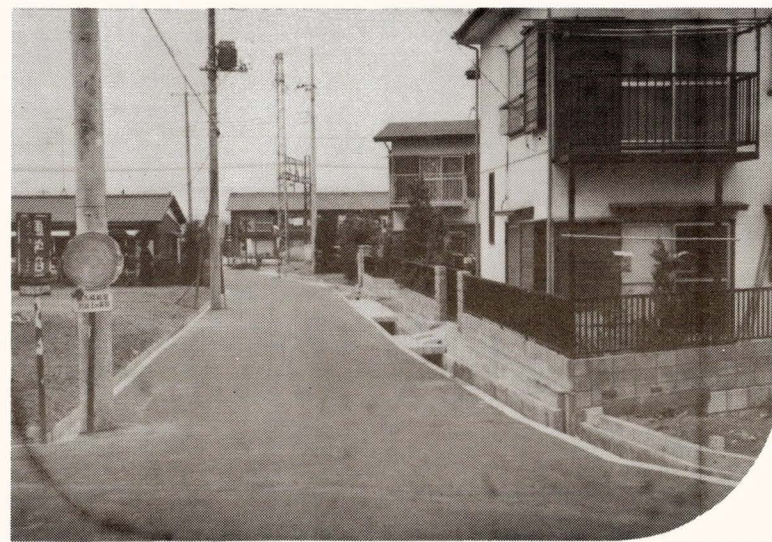
新井 1 号線道路改修
