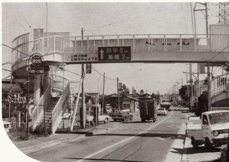
平山歩道橋設置
