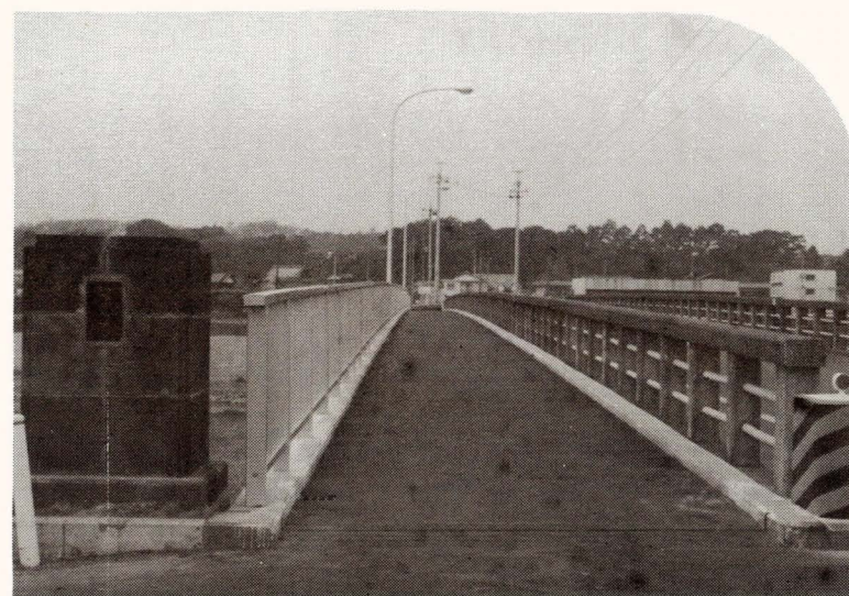
一番橋人道橋設置
