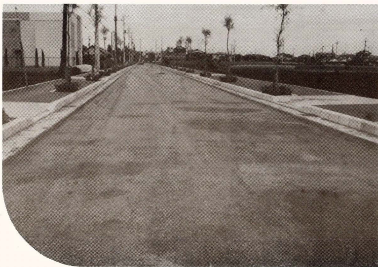
平山 8 号線道路改修
