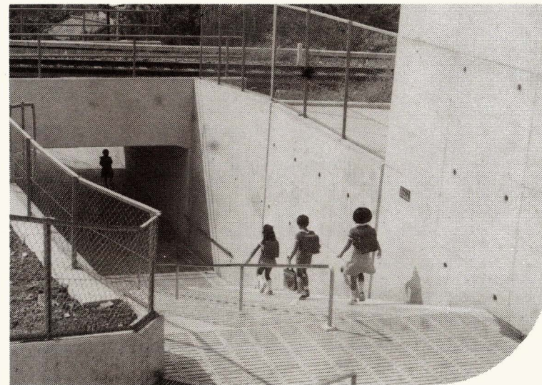
程久保小学校地下通学路築造
