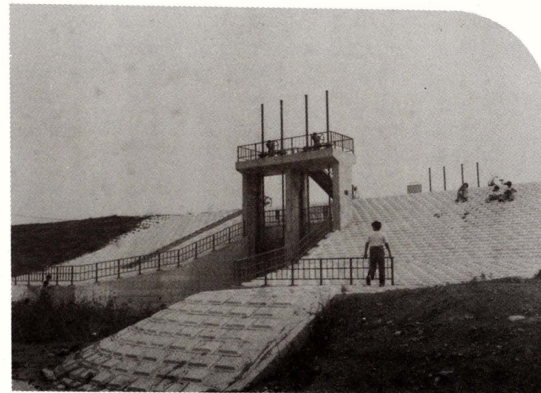
新坂下樋管設置
