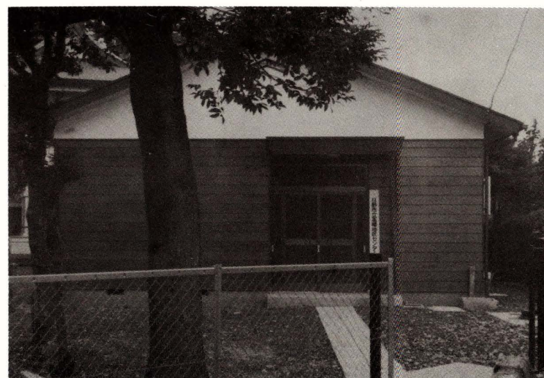
高幡地区センター新築
