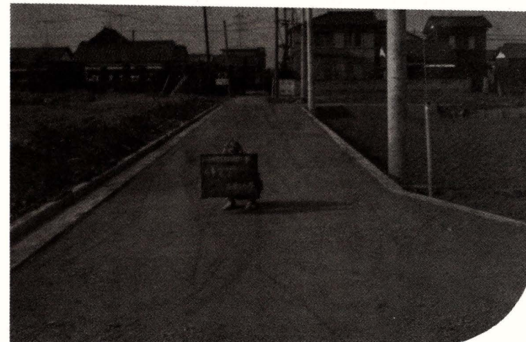
下河内 1 号線道路整備
