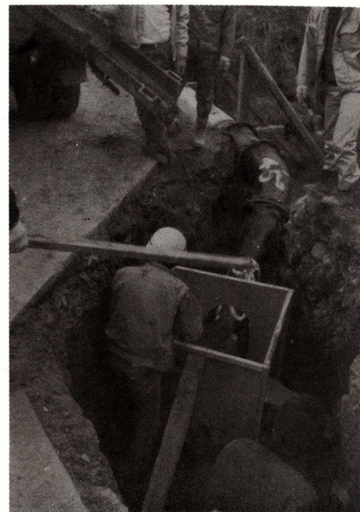
三沢七二三と南平二丁目二四番地先間 配水管新設
