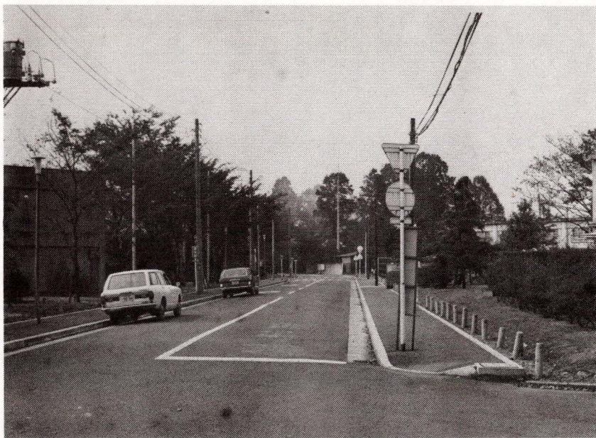
歩道設置（多摩平幹線 2 号線）
