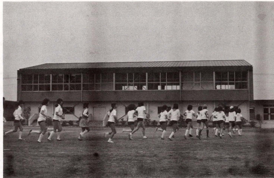
高幡台小学校屋内運動場
