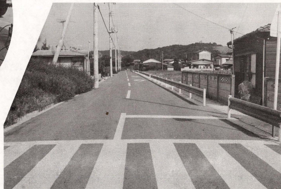
ガードレール（補助 1 3 号線）
