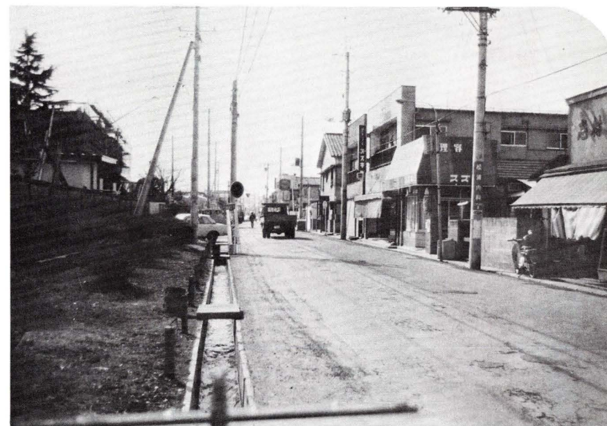
側構改良工事（柳町）
